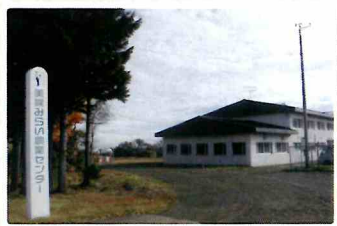
美幌みらい農業センター
